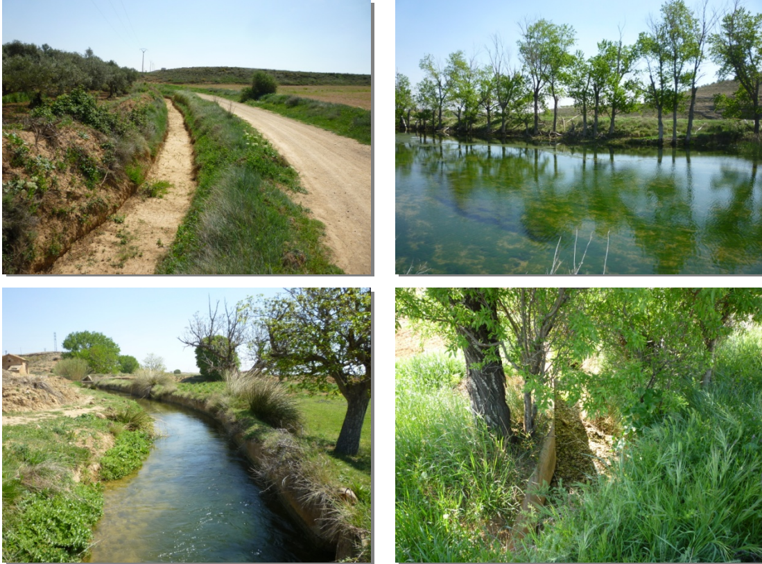
Detalles de infraestructuras hidráulicas en Belchite
