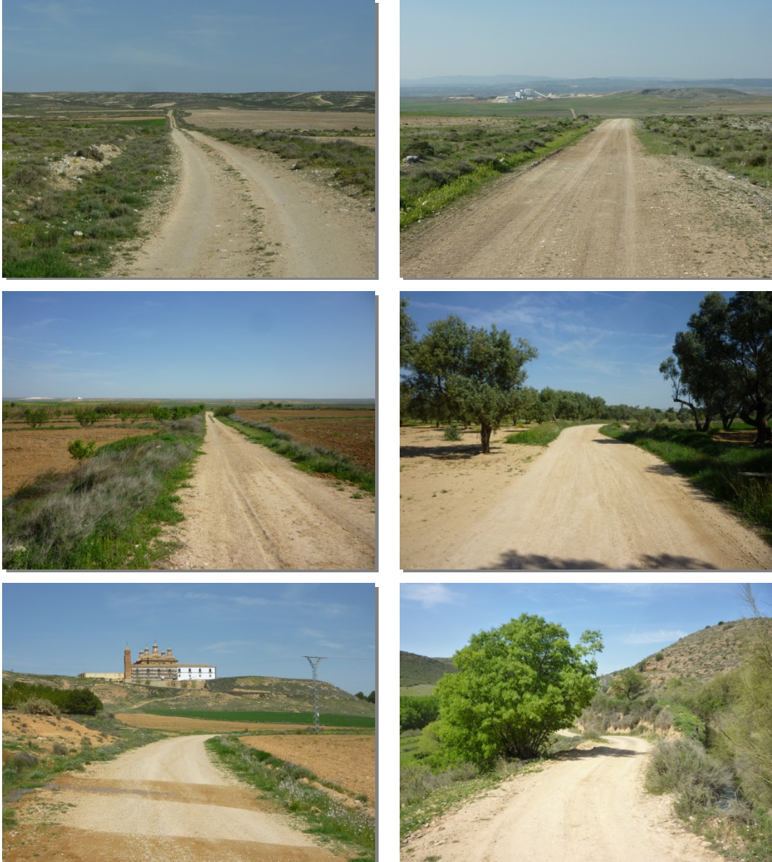
Detalles de infraestructuras rurales viarias
